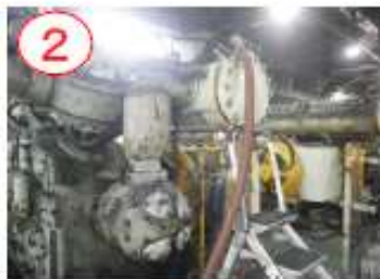
② 洗浄部分写真
