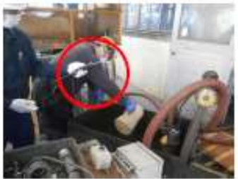
投入中の測定 (液面から約800mm上部)
